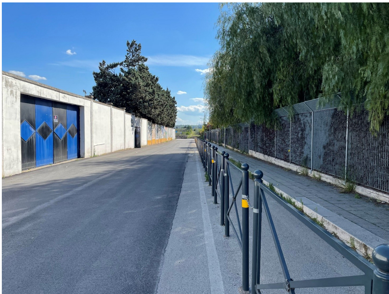
Rifacimento completo strato superficiale di asfalto
