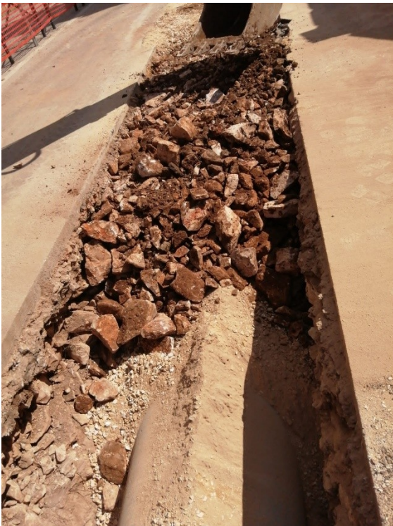
Taglio e demolizione di asfalto
