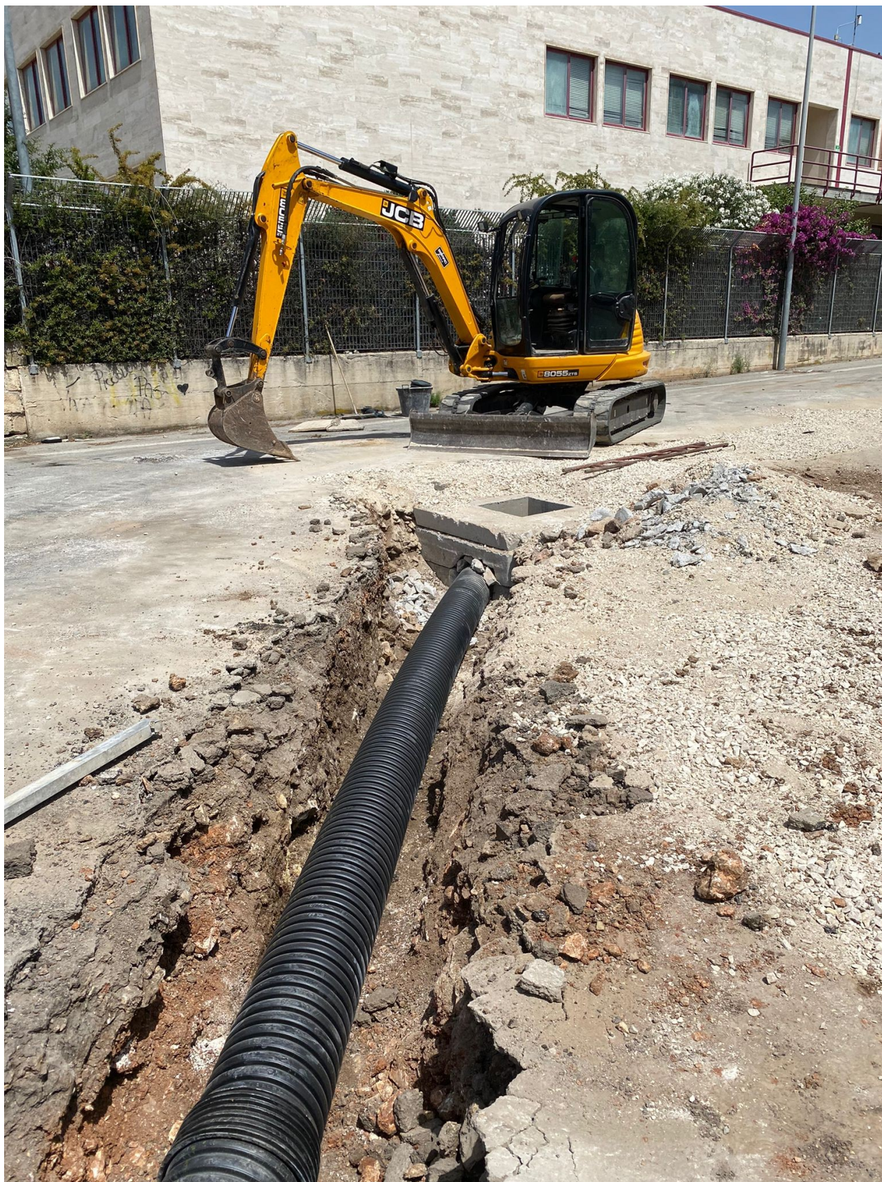
Adduzione al pozzetto di convogliamento zona posteriore
