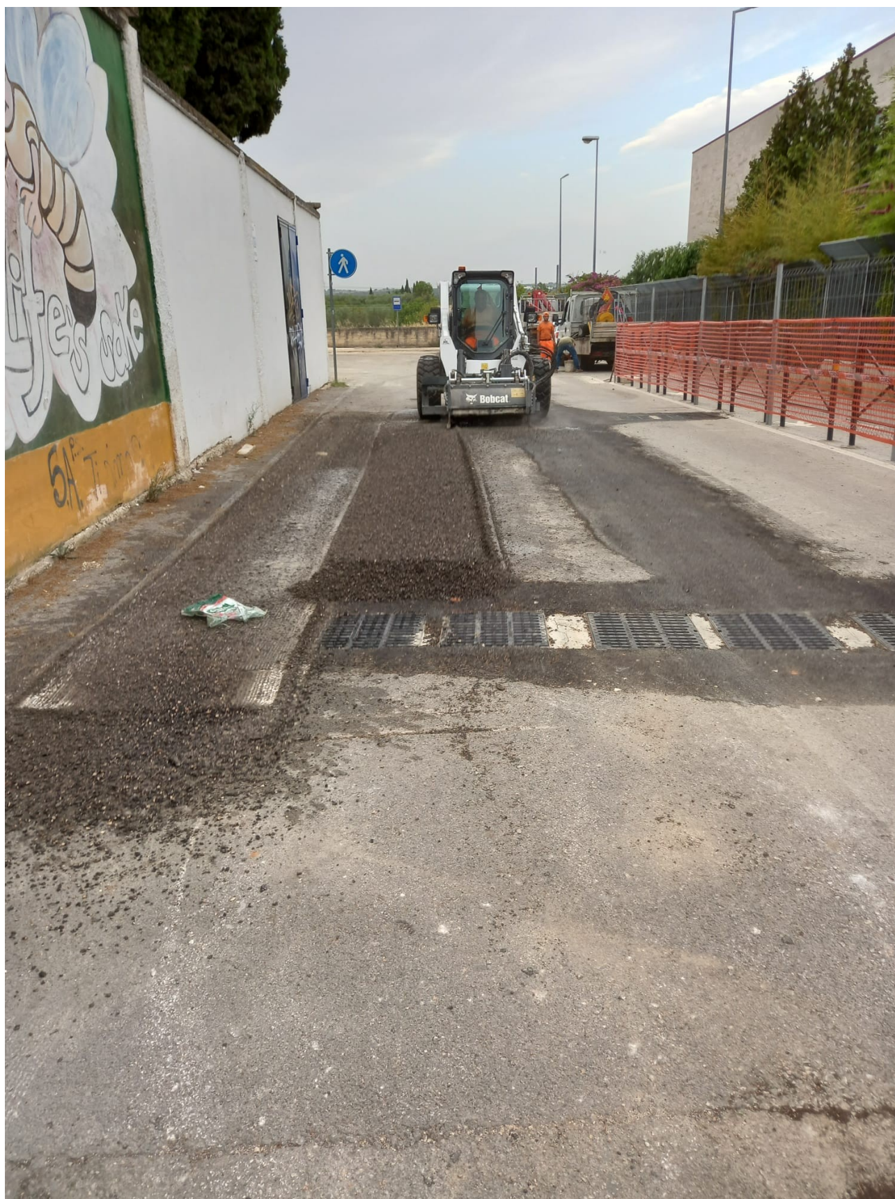
Caditoie di raccolta e scarificazione completa finale
