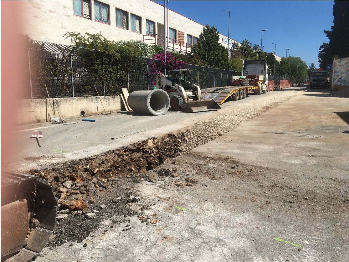
Tronco di adduzione sulla via di accesso al liceo
