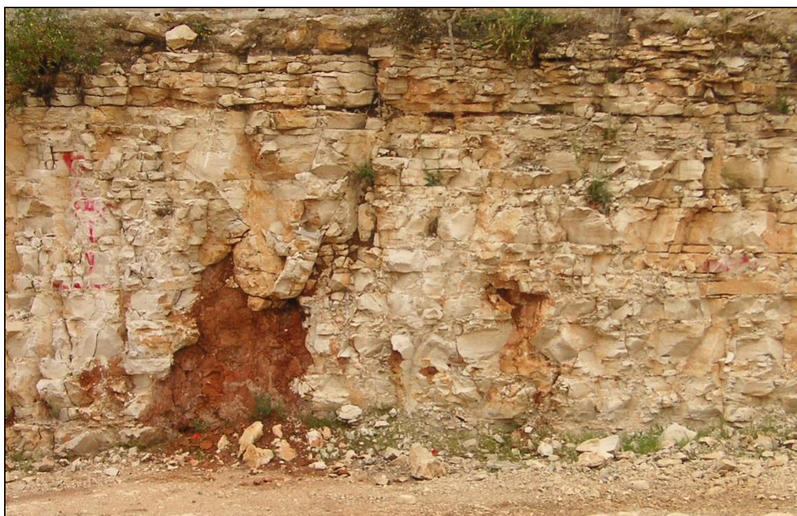
Foto 5 - Particolare di uno scavo di fondazione con evidenza degli strati calcarei superficiali ad alta fratturazione ("Chiancarelle") e fratture di interstrato con inclusioni di terra rossa -
