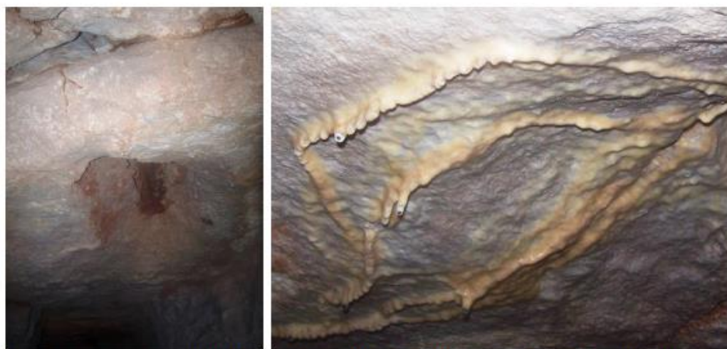
Fig. 3.4 - Forme carsiche: a sinistra, una delle piccole cavità intercettate dalla volta della galleria; a destra, concrezionamento alla volta, in forma di cortine e cannule ad uno stato iniziale di accrescimento, con evidente stillicidio.
