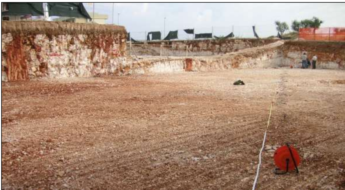
Panoramica scavo di fondazione, particella 1333 Comparto C1
